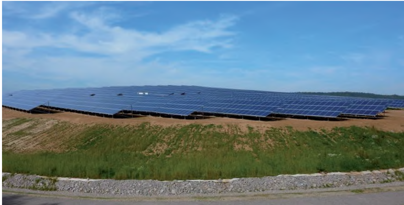
Die installierte Photovoltaik-Anlage auf der Deponie Mathiasgrube hat eine installierte Leistung von 1.712 kWp. Im Jahr 2025 wurden hier 1.440.150 kWh Strom erzeugt.
